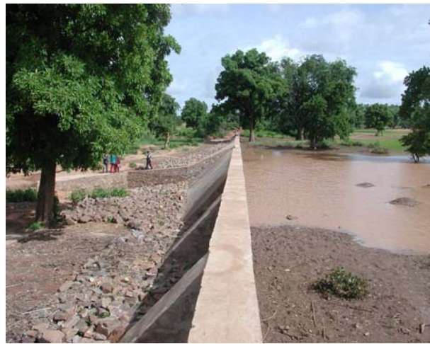
Micro Barrage de Kokeni (Vue de profil)
